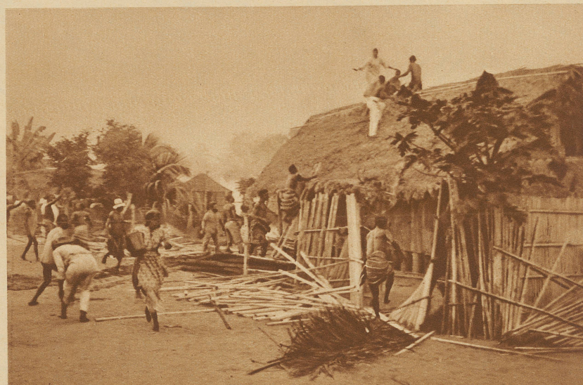
Das Dach einer feuergefährdeten Hütte wird heruntergerissen und die Habseligkeiten werden in Sicherheit gebracht
