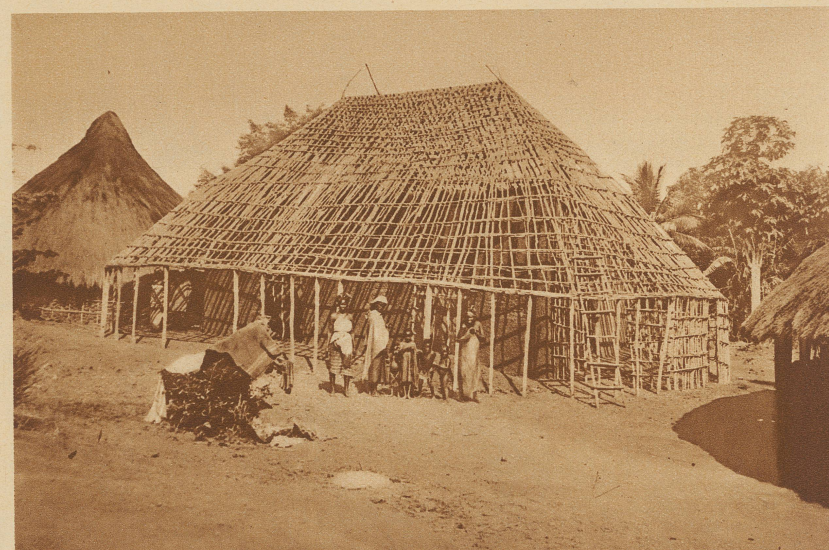
Wiederaufbau: Das Gerüst einer Negerhütte
