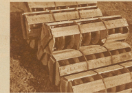
Hänge-isolatoren, die ihre Funktionen noch nicht erfüllen.
