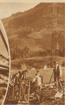
Vorbereitungen zum Schlaf. Das Drahtseil auf die Seile wird im Wechsel befestigt, raschell in die Höhe gezogen und von einem Mast zum andern geführt.
