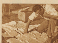
Der Chefmonteur sieht sich in dem verwetterten Leitungsblech zurechtfindend.
