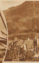
Vorbereitungen zum Schlaf. Das Drahtseil auf die Seile wird im Wechsel befestigt, raschell in die Höhe gezogen und von einem Mas zum andern geführt.
