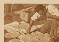
Der Chefmonteur sieht sich in dem verwetterten Leitungsblech zurechtfinden.
