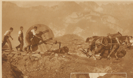
Die Leitungs-Drahtseile, über 1100 Meter lange Teilstränge, sind auf Seilwinden oder Rollen aufbewahrt. Im Transport aus der Talstufe in die Bergbahn ist ein saures Saug-Arbeits für Mann und Ross.
