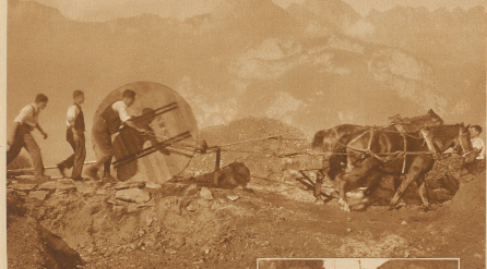
Die Leitungs-Drahtseile, über 1100 Meter lange Teilstränge, sind auf Seilwinden oder Rollen aufgebunden. Im Transport aus der Talsohle in die Bergeshöhe ist ein saures Stück Arbeit für Mann und Ross.
