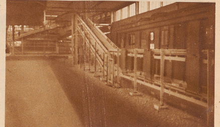
C. Im Postbahnhof. Postwagen stehen zur Leerung bereit. Von den beiden laufenden Bändern, auf die die Pakete gelegt werden, führt das obere in die Ausgabe und das untere in den Versand
