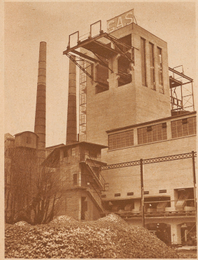
Das städtische Gaswerk hat zu andern Erweiterungen einen neuen Platzraum bauen lassen.
