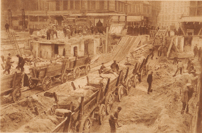
wurde eine Baustelle mit Schaufel, Wagen und Pferden ausgeschachtet. Ein Heer von Arbeitern war für die vielen einzelnen Manipulationen nötig
