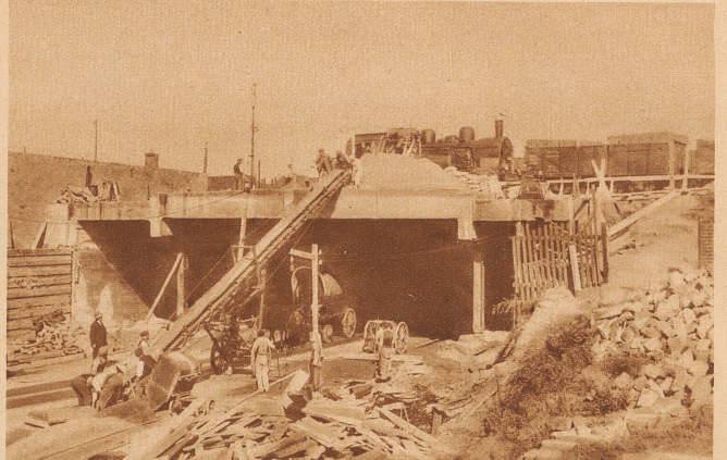
arbeitet man mit einer modernen Ausschachtungsmethode am laufenden Band, das direkt zu den Eisenbahnlöchern führt. Benötigte Arbeiter: Sechs
