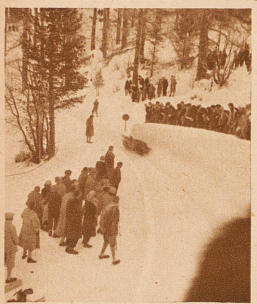
Eine Bobbahn ist ein kleines technisches Kunstwerk. Rennbahn und Zuschauertribünen sind aus Schnee gebaut und werden durch Besprengen mit Wasser zum Vereisen gebracht. In den Kurven sammeln sich die Zuschauer mit Vorliebe, denn jene bilden die Sensation des Bobrennens
