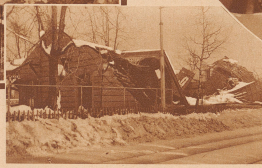
Unter der ungeheuren Schneelast, die sich letzte Woche auf die Dächer legte, brach die Konzerthalle in Neudorf-St. Gallen zusammen (The. Sauter)
