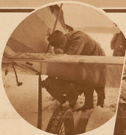
Das DH. 5-Flugzeug mußte bei Herzogenbuchsee notlanden. Zum Abtransport mußten die Tragflächen demontiert werden (Phot. Link, Basel)
