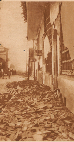
Nicht eingestürzte Häuser wurden daran beschädigt, daß sie einen ständigen Gefahr für die Bevölkerung bilden. Der angrenzende Schaden wird auf 350 Millionen Franken geschätzt
