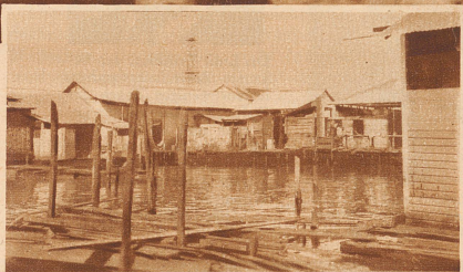
Auch die Siedlungen stehen im Wasser. Aus alten Brettern und Blechen erstellt sich die ärmere Bevölkerung ihre Wohnstätten. Wenn es einmal brennt, was nicht selten vorkommt, verschwinden ganze Pfahlbauerdörfer in kurzer Zeit
