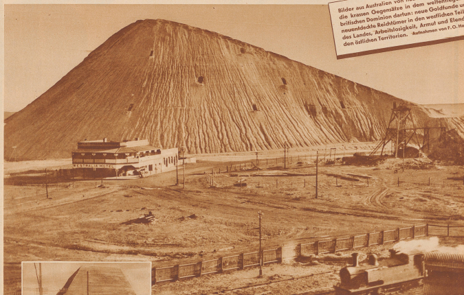
In den Mitternächten von Westaustralien liegen schneebedeckte Berge und Pyramiden Abraummaterial, hinterlassen aus früheren Abbauperioden. In jüngerer Zeit waren die Goldgrubenregionen von so reichlichen, daß große Mengen an Fällmaterial die Flur nicht verlassen wurden konnten. Mit den moderneren chemischen Ausarbeitungsmethoden ist es möglich, noch ungenutzte Werte aus diesen brachliegenden Schmelzbergen herauszuholen
