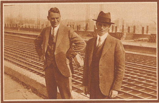
Dr. O. H. Ammann (rechts) mit einem Ingenieur im Juli 1931 auf der Fahrbahn der Brücke unmittelbar vor der Vollendung Foto Dr. R. Welti
