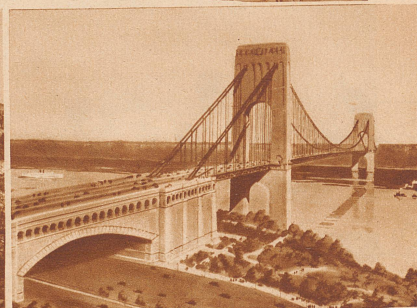
Die Brücke in ihrem späteren projektierten Endzustand. Die Eisentürme sind mit Stein verkleidet
