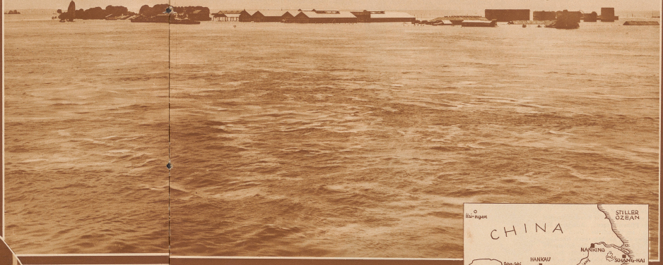
Die Handelsniederlassungen um Hankau waren durch Dämme gegen das Wasser geschützt. Der Strom hat die Dämme weggeführt, und die Lagerhäuser, Siles und Oelkants stehen jetzt in einem mehrere Meter tiefen See
