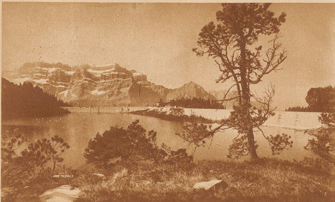
Der Stausee des Kraftwerkes Sernf-Niederbach. Der See liegt 1620 Meter über Meer im Talkessel auf Garichte im Kärpgebiet und fasst rund 3 Millionen Kubikmeter. Er mußte mit zwei Mauern von 230 m Länge und 36 m Breite bzw. 225 m Länge und 15 m Breite mit zusammen 59 000 Kubikmeter Beton errichtet werden.
