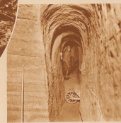
Im Berner Jura, nahe Solothurn, ist ein unterirdischer Bunker, der als Schutz für die Artillerie errichtet wurde. Die Bunker sind durch die Artillerie errichtet worden, die sich nicht selten über Stunden in die Höhe ziehen.
