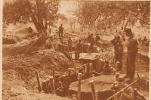
Grabbecken an der Nordwestgrenze. Zum Schutz vor der Sprengwirkung der feindlichen Artillerie- und Handgranatenwürfer wurden die Schützengraben nicht geradlinig, sondern möglichst gewunden gebaut.
