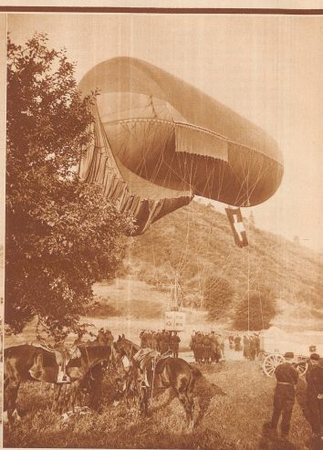
... der echte Fesselballon, wie er von Flantern im Waldweg die feindlichen Fronten beobachtet. Die Konstruktion der wohlbekannteren »Wurms« hatte den Vorteil, daß man sie weitgehend gegen Abwind sichern und gegen Stürme widerstandsfähig machen konnte. Sie war daher das geeignetste Hilfsmittel zur Aufklärung in eingebegrenztem Grenzabschnitt.
