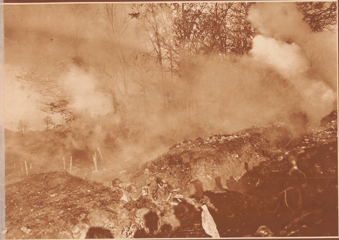
Dünne Pansierhaub liegt über den Gräben, die durch eindringende Gase verunreinigt werden
