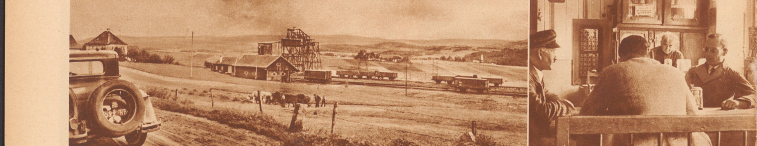
Schwanzkirschen im Bayrischen Wald haben ein Bewerger, da wegen Mangel an Benutzmitteln eingeleitet werden mußte. Keine Bank gab Geld. Wirtschaftlich mit 50.000 Wärs wurde es in Gang gesetzt. 30-40 Arbeiter fanden Beschäftigung. Die Kasse geht heute aus der Grube durch ganz Deutschland! In der Umgebung der Kolonialguthaben gibt heute niemand mehr an die alljährlichmachende Golddeckung.
