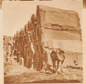
Hier wird die Bauweise deutlicher. Wie Bienen lagern die Wohnungen übereinander. Man schleicht sie so hoch auf, wie es der Unterbau gestattet. Innentreppe gibt's keine. Auch keine andere Öffnungen als die Tiere
