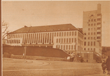
Das neue Kirchgemeindehaus Zürich-Wipkingen wurde kürzlich eingeweiht.
