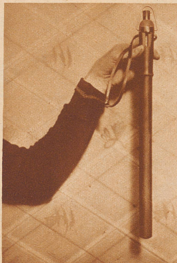
Der Gasmuniknippel , der kürzlich an der Leipziger Messe von einer Berliner Waffenfabrik gezeigt wurde. An dem Gummiknippel, der als Schlagwaffe benutzt wird, ist ein Scheintodrevolver angebracht; drückt man auf einen Hebel, dann explodiert die Gaspatrone und der Gegner wird auf eine Viertelstunde außer Kampf gesetzt
