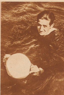
Eine Berliner Firma bringt einen neuen Rescue-Apparat für Ertrinkende den Handel, der großes Aufsehen erregte und vielleicht geeignet ist, das ganze Rettungswesen zu revolutionieren. Es ist ein kleiner flaschenartiger Apparat, der innen mit Carbide gefüllt ist. Im Falle von Gefahr wird er einfach in der Nähe des Ertrinkenden ins Wasser geworfen, versinkt zunächst, taucht dann aber wieder auf, da das Carbide im Wasser Gase entwickelt, die ihn an die Oberfläche treiben. Eine Ballonhülle, die am Kopf des Apparates angebracht ist, wird durch das eindringende Gas aufgebläht und hat eine derartige Auftriebskraft, daß sich drei Personen an dem Apparat festhalten können. — Links: der sogenannte Kiekbusch-Apparat vor dem Hereinwerfen ins Wasser, rechts der aufgeblähte Ballon, an dem sich der Ertrinkende festhält
