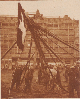
Mit langen Stangen wird der Mast noch weiter in die Höhe gehoben. Schon flattert die Schweizer Fahne lustig im Wind
