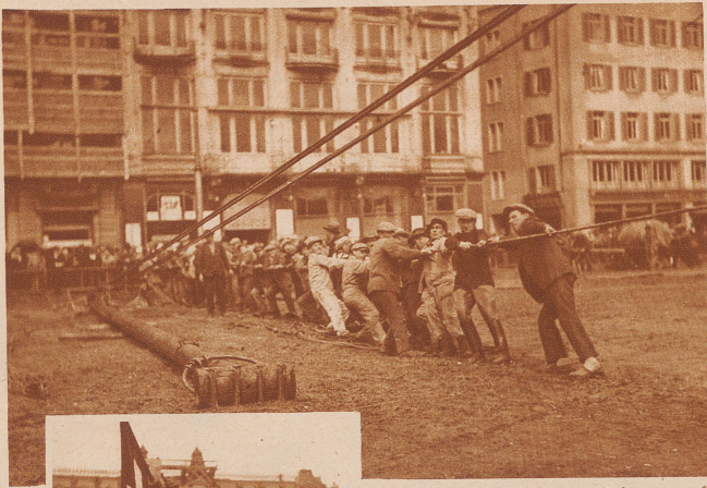
Um einen der vielen schweren Zeltmasten aufzurichten, braucht es viele Leute. Erst wird der Mast von den Männern gehoben. Sobald er eine gewisse Höhe erreicht hat, können die Männer auf der andern Seite am Seil ziehen. «Ho-rutsch, Ho-rutsch!» ruft der Aufseher
