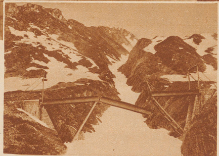
Daß in einem solchen Lawinenzug eine zusammenschiebbare und zusammenlegbare Brücke das einzig Zweckmäßige ist, veranschaulicht dieses Bild
