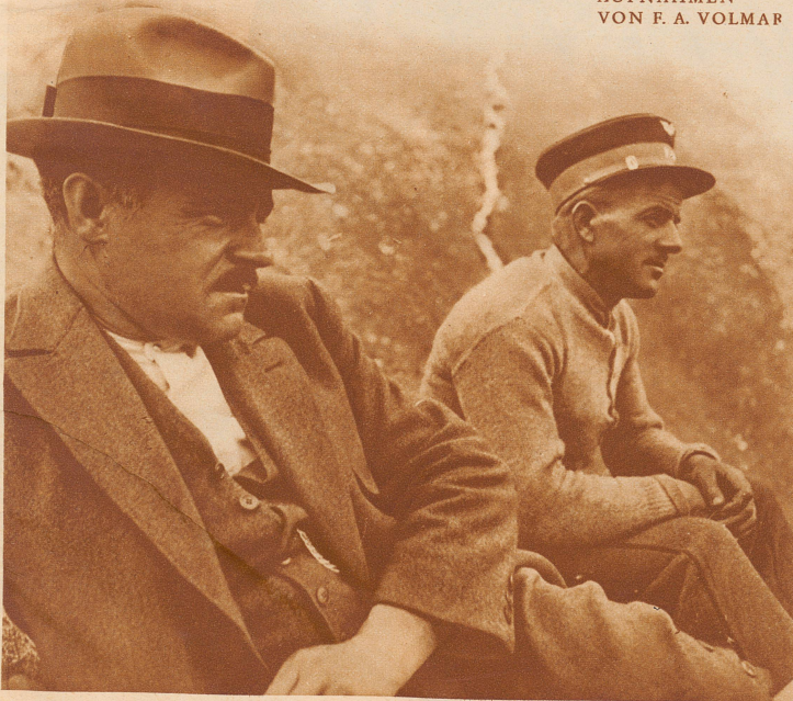
Mittagspause: Bahningenieur und Vorarbeiter betrachten die nahezu fertig montierte Brücke
