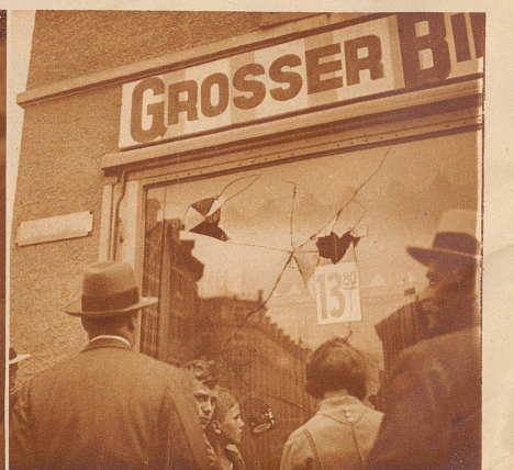
Am andern Tage. Eines von den demolierten Schaufenstern in der Gegend der Turnhallenstraße-Langstraße Aufnahmen Schmitt
