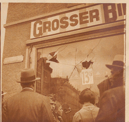
Am andern Tage. Eines von den demolierten Schaufenstern in der Gegend der Turnhallenstraße-Langstraße
