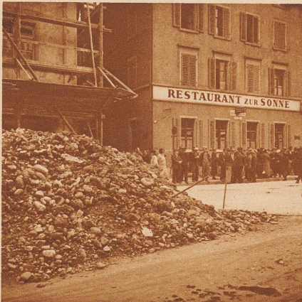
Das Restaurant zur «Sonne», der Sitz der Streikleitung an der Hohlstraße. Auf dem Platz ein Haufen Aushubmaterial, von wo die Auführer die Steine zum Bombardieren der Polizei bezogen
