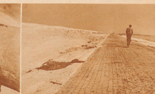
An der Krone mißt der Damm 90 Meier in der Breite. Auf dem Damm wird eine Ausstraße, ein Weg für Fußgänger und ein Fahrweg für den Spitzer soll hoch über die Doppelgänger Eisenbahn über den Damm gebaut werden. Eine Fähr über den Damm verbindet ganz phantasievolle Brücken. Der gedruckte Sand wird in der Sonne weiß wie Schnee.
