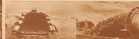
Als Grundlage für den Damm wurden sogenannte "Clink-stücke" eingesetzt. Sie sind aus mehreren Fachwerksteinen zusammengesetzt, 100-120 Meier lang, 30 Meier breit; sie wurden mit Seilen beladen und dann an der beabzichtigten Dammlinie verankert.
