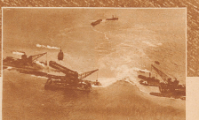
Die Dammschiffung eines Tag vor dem Abschluß. Immer höher schieben sich die beiden Dammschiffe zusammen. Zwei große, auf Ponton montierte Greifbagger heben Sand und Schlamm vom Meergrund und schütten die Material in die Lücke. Sonntag den 29. Mai, mittags 1 Uhr, war die letzte Öffnung geschlossen.
