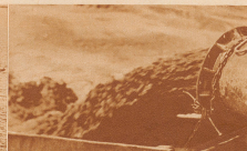
Während dem Bau entfiel, ist nicht Wasser, sondern Schlamm. Durch niedrige Sogger wurde der Schlamm aus dem Meerboden gezogen und diese dann zum weitem Aufbau des Damms.
