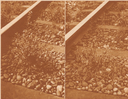
Ungern geduldet im Sommer die Unkrautwurzeln des Schotens der SBB. Zu seiner Verfüllung wurde früher ein ganzes Heer von Bahnarbeitern aufgestellt, später schaffte die Jänmaschine den Boden zwischen den Schwellen an ...
