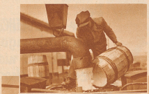
1844: Die Seidung des Unkrautverfüllungsprozesses mit Natrumchlorid und Wasser. Jeder Wagen fällt 16 500 Liter Flüssigkeit. In trockenem Zustand ist die Lösung energiegelicher.
