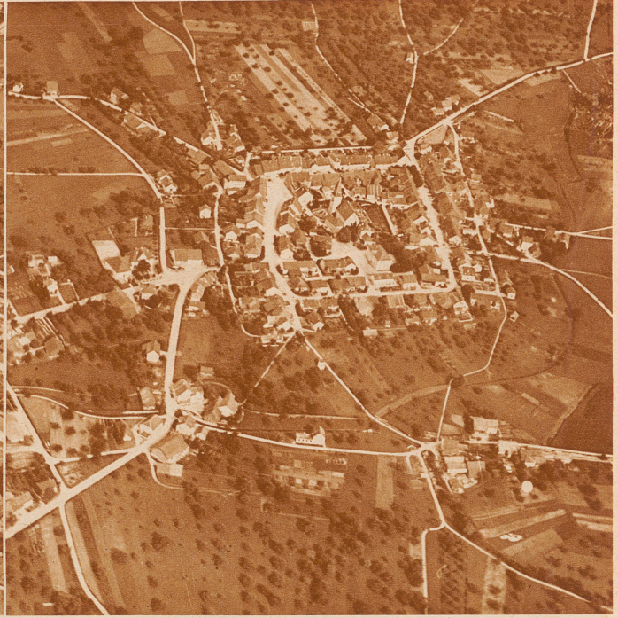
ELGG Die nahezu quadratische Anlage erhebt sich am Ort einer alten römischen Siedlung und in der Regelmäßigkeit ihres Planes schimmert die alte römische Bautradition noch durch. Manche Städte und Städtlein der Schweiz, die man nach ihrem Grundriß unbedingt auf ein römisches Castrum zurückführen möchte, sind erst viel später entstanden, in ihrer Grundform aber dennoch vom alten Rom abhängig, da eben noch lange Jahrhunderte hindurch die Vorstellung von der Würde der städtischen Siedlung durch die überwältigende römische Bautradition bedingt wurde. — Elggs Entwicklung zur Stadt wurde vorzeitig unterbrochen; in einem Streit mit dem nahen Wil verlor es sein Stadtrecht, — was öffentlich so bekundet wurde, daß die Wiler die Stadttore von Elgg einfach mit nach Hause nahmen, — damit fiel dann die Verpflichtung zu «städtischem» Bauen dahin.
