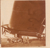
Allen an dieser Junkersmaschine «G 38» an. Preisgeld. Ihre Spannweite beträgt 44 Meter, die Spannweite der menschlichen Konkurrenz nur 18 Meter. Es flog 10 Passagiere und eine Besatzung von 6 Mann. Die Motoren sind in die Flügel eingebaut.
