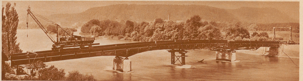
Neue Verbindung Schweiz—Deutschland. Die neue Brücke über den Rhein zwischen dem schweizerischen Koblenz und dem badischen Waldshut, die jetzt im Rohbau fertiggestellt ist und demnächst dem Verkehr übergeben wird Aufnahme Bauer
