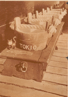
Feuer breitet sich auch auf dem Schiff nicht aus, wenn man es sofort mit Wasser bespritzt. Oben auf dem Kaminrohrdeck stehen in langen Reihen die Wasserkübel, die zum besseren Anfaßen mit Strickträgern versehen sind
