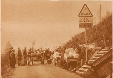
Das Dorf im Morgengraue. Zahl Wohnhäuser und viele Scheunen sind niedergebrannt. 80 Menschen haben dadurch Hab und Gut verloren, sind obdachlos geworden. Sech Wohnhäuser und die Kirche stehen noch. Der Kirchhof ist durch das Feuer höchstschädlich. Wie sehen die Leute für die Erhaltung der Kirche bereit. Um drei Uhr droht der Turm in Brand zu geraten. Drei Schiffe fliehen nach dem Brand der Uhr mill. Die Feuerwehr rüsten die größten Auszügegen auf die Erhaltung der Kirche. Um sieben Uhr morgens hält der Pfarrer die Predigt, die Kirchenscheitel gegen Brand auf der Wiese, die Gläubigen gehen hinein und die Wassertrichter spritzen immer noch gegen die Aufbaumauern.
