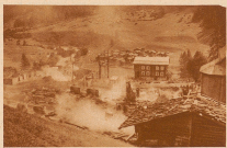
Wir sehen von der Kirche aus über das vom Feuer zerstörte Dorf. Im Hintergrund liegt an der Ebene der Weiße Bodensee. Der ziemlich starke Wind weht in der Nacht von Westen. Bei nördlicher Windrichtung wäre der Weiße nicht zu retten gewesen. (Autobahn Zürich)
