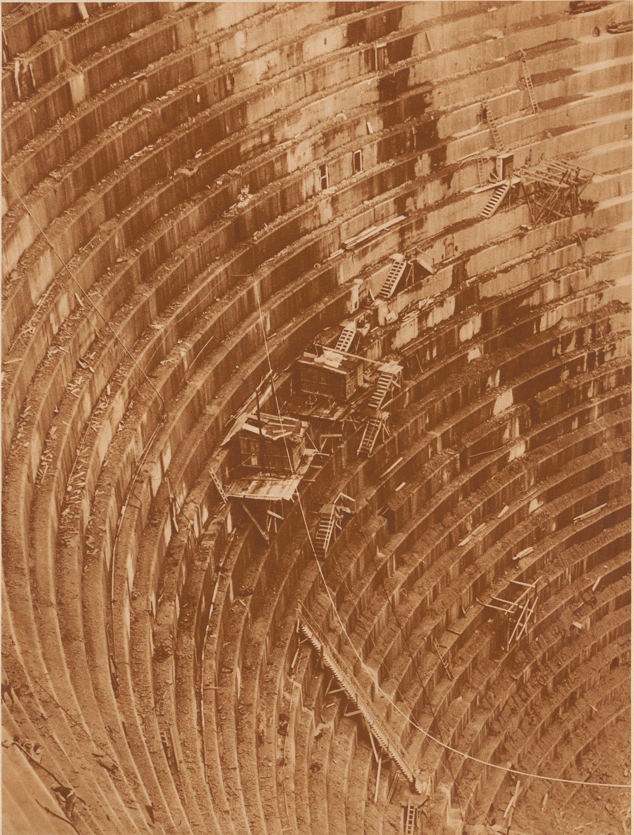
Das ist ein Ausschnitt aus der großen Spitalamm-Sperrmauer des Grimselwerkes, zur Zeit, da die Mauer fertiggestellt war und vom Bauschutt gereinigt wurde. Die Mauer ist 114 Meter hoch, an der Basis 65, an der Krone 4 Meter breit. Die zahlreichen Abstufungen sind gemacht, damit eine eventuelle spätere Steinverkleidung möglich wird. Die Absätze sind 2 Meter hoch und 1 Meter breit. Die kleinen Hütten, die wie Schwalbennester an der Wand kleben, sind Baubaracken. Sie vermitteln einen guten Maßstab der Riesenausmaße des Bauwerkes. Die sichtbaren Öffnungen in der Mauer werden zum Teil zum Messen der Mauertemperatur benützt, zum Teil sind es Fugen, die zur Konstruktion nötig waren
