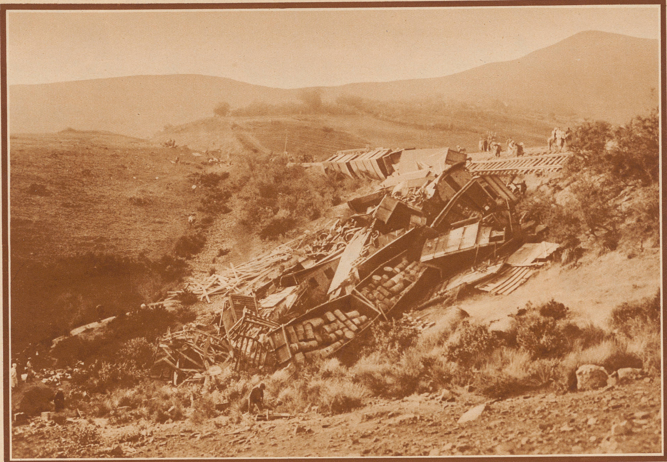
Schwere Zugkatastrophe in Algier. Auf der Linie von Oran nach Oudjda bei der Station Tlemcen ereignete sich ein Zugunglück von riesigen Ausmaßen. Auf dem durch heftige Regengüsse schadhaft gewordenem Bahnunterbau entgleiste ein Militärzug der Fremdenlegion und stürzte über einen 30 Meter hohen Abhang in die Tiefe. 61 Legionäre und 5 Mann vom Zugpersonal kamen ums Leben
