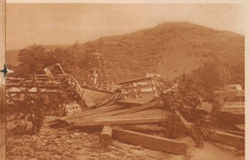
Durch Hochwasser zerstörte Brücke über einen kleinen Zufluß bei La Vauzelle in der Gegend von Valence (Südfrankreich).
