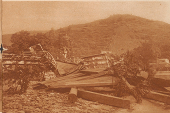
Durch Hochwasser zerstörte Brücke über einen kleinen Zufluß bei La Vaulx in der Gegend von Valence (Südfrankreich).
