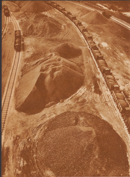
Blick vom Kohlensturm des Gaswerkes Schlieren auf die Koko- und Kohlenstapelplätze. Auf Zufahrtsgleisen rollt die Kohle in ganzen Zügen ins Werk, in ganzen Eisenbahnzügen verläßt die Koks die Fabrik.
