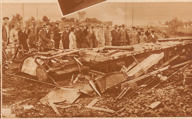
In der Nähe von Temesvar in Rumänien entgleiste infolge falscher Weichenstellung ein aus Güter- und Personenwagen zusammengestellter Eisenbahzug. Die Güterwagen fuhren mit solcher Wucht auf die Personenwagen auf, daß diese gänzlich ineinandergeschoben wurden. 24 Personen kamen um, 17 wurden schwer verletzt. — Bild: Was von einem Personenwagen übrig blieb
