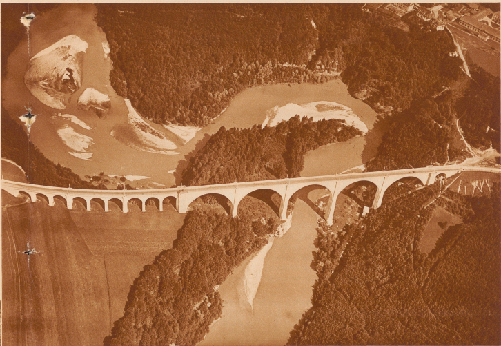
Peyolle-Viadukt bei Freiburg;
