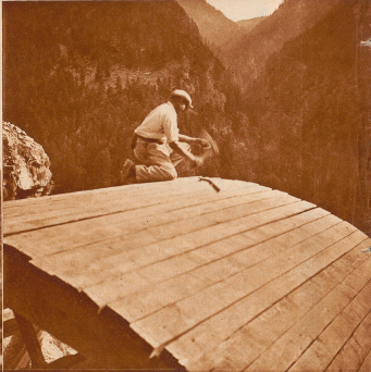
Beim Dogenbau an der neuen Straße
