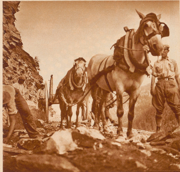
Beim Bau wurden sardische Pferde verwendet, die leicht und wendig sind und an Füssen und Hänge gewohnt
