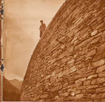
Solche Trockenmauern stehen unterwegs die. Stützbojen und Brücken. Fox und schin. Bese Arbeit. Alles vom italienischen Unternehmer gebaut für einen Betrag, der den Schweizer Straßenbauern nur ein bedauerndes Achselzucken einbrachte. So sehr man die Vierkilometer-Straßenstück da, zwischen dem armen Dörflchen Spruga und dem vergessenen naheliegenden Tälerloch im obersten Onsernonen. Jenseits der Grenze kreucht die neue Straße unvermerkt ab. — Schuldlos Italiener. Erst bei uns zu bauen, ehe sie an sich selber denken!
