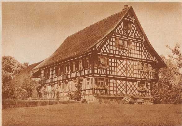
Ein sehr schönes Fachwerk-Bauernhaus aus der Gegend von Arbon. Es ist das typische ostschweizerische Bauernhaus mit einem kompletten Fachwerk in leuchtendem Rot, vielfach in einem natürlichen braunen Holzton
