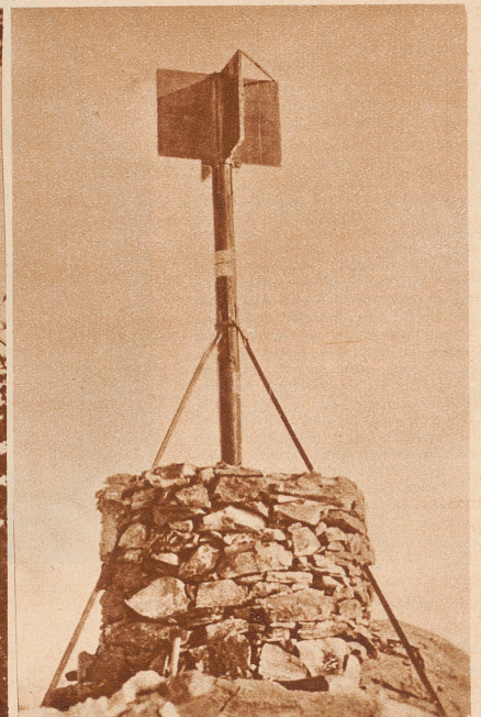
Das höchste trigonometrische Signal in der Schweiz. Der Steinmann mit dem Richtungskreuz auf der Dufourspitze, dem höchsten Punkt im Monte-Rosa-Massiv. Es steht 4638 Meter über Meer. Ingenieur Bühler benötigte mit drei Gehilfen fünf Tage angestrengter Arbeit für die Errichtung dieses Signals
