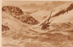
Die zerstörte Telefonleitung. Diese Leitung, die eine Spannweite von über 1000 Meter aufwies und im tiefsten Punkte 180 Meter über dem Boden hing, wurde dem Piloten zum Verhängnis.
