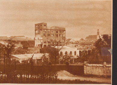
Sogar verhältnismäßig junge Bauen fallen der Krise zum Opfer; Zedernhaus bei Duisburg, das abgebrochen wird
