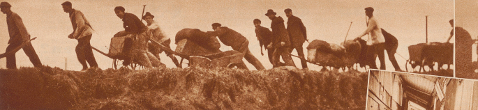
Der Kohleschuttman steht im großen Berge in der Zehle. Es ist verboten, ihn wegzuschleppen. Aber um das Verbot kümmern sich die Arbeiter nicht. Das schwebende Himmelsnetz wird von ihnen in Höhe gefüllt und nach Hause befördert. In der Nähe der Schlammbänne sieht man in den Morgenstunden lange Züge aus kleinen Handkarren nach Hause wandern.
