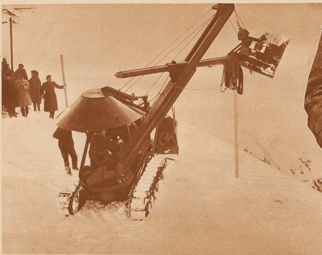
Internationaler Schneepflug-Wettbewerb. An zwei tiefverschneiten Pässen der Alpes Maritimes in Süd-Frankreich fand in diesen Tagen der 3. Internationale Schneepflug-Wettbewerb statt. Bild: Ein Schneepflug, der gleichzeitig als Schneebugger benützt werden kann, in Tätigkeit
