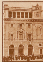
Der monumentale Eingang der Gregorianischen Universität. Dieser Neubau in neuer romanischer Form ist eine der schönsten Bauten Roms
