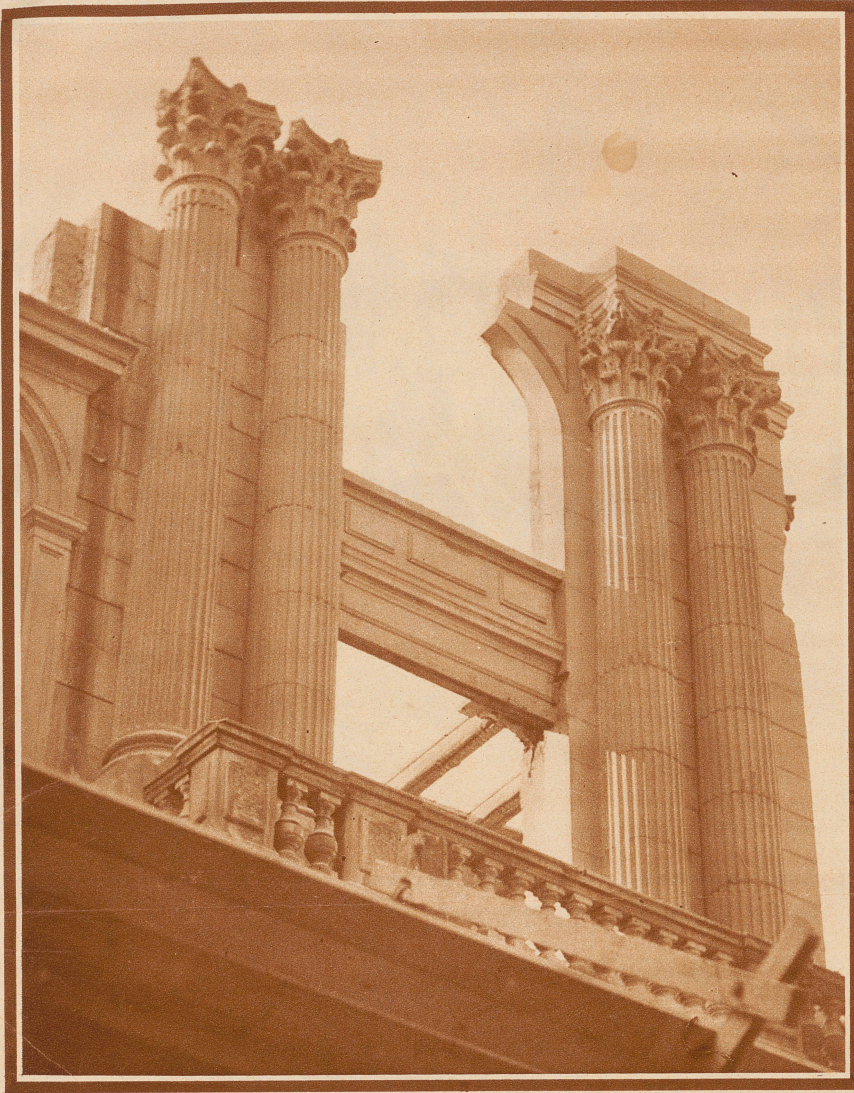
Säulen fallen. Am Bahnhofplatz in Zürich wurde vor 50 Jahren ein für die damalige Zeit monumentaler Prachtsbau, das Hotel Victoria erstellt. Nun toben sich die Zerstörungswerkzeuge einer Abbruchfirma an dem Gebäude aus. Noch ragen einige griechische Säulen stolz in die Luft, aber in einigen Tagen wird das Hotel Victoria I. Ranges, in dem Hunderte von Berühmtheiten aus allen Ländern, Fürsten, Könige, Kardinäle und hohe Militärs logierten, vom Erdboden verschwunden sein Aufnahme Staub
