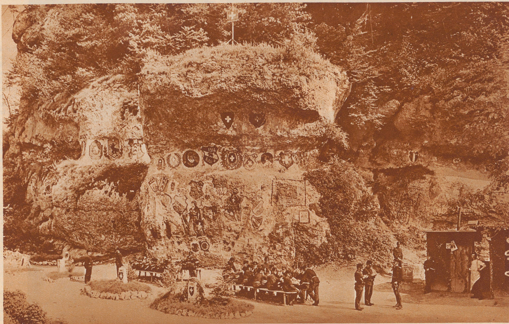
Das Soldatendenkmal bei den Kessilochbrücken im Birstal.
