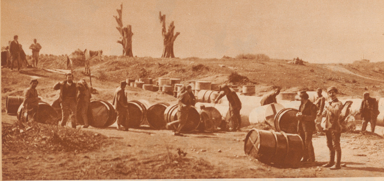
Montenegrinisches Stangenart im ersten Balkankrieg. Leere eiserne Benzinfässer wurden mit einem Holzgerüst ausgekleidet, das ringsum einen Spalt von 10 cm abließ, der dann anbestrichen wurde. Bei der Belagerung von Skutari im November brach Angriff der Stadt von der See-Seite aus, wodurch die Fässer von je drei Mann vor sich hergeführt und hinten so einem guten Kapselung, der auch das belagerte feindliche Infanteriefeuer wärmschloß machte.
