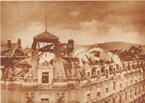
Am 1. Mai 1932 brach im Gebäude der Obertelegraphendirektion an der Speichergasse in Bern ein Brand aus, durch den der vierte Stock, der Estrich und das Dach vollständig zerstört wurden
