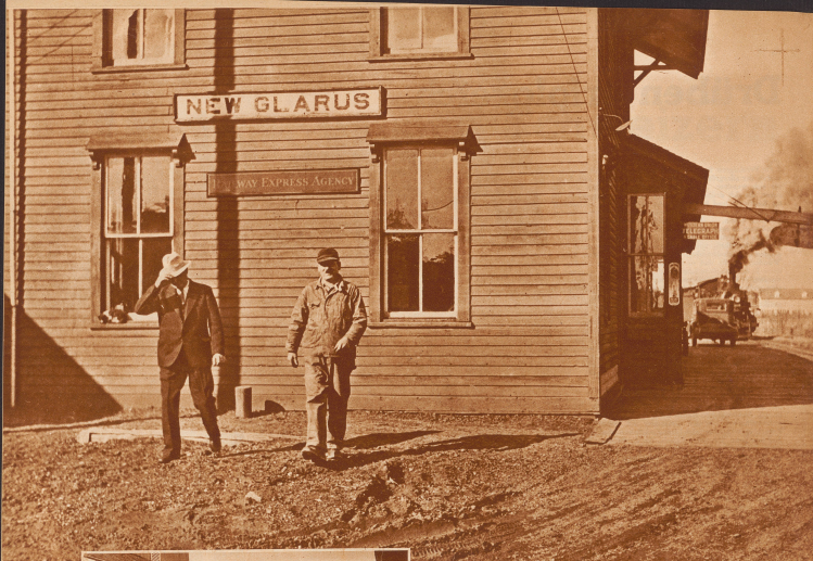
Der Bahnhof von New Glarus. Eine typische Station, wie sie zu Tausenden - eine gleich wie die andere - an den besten Linien von U.S.A. und an den Nebenbahnen zu finden sind. Nur der Name unterscheidet diese Stationen. New Glarus liegt sechs Stunden von den nächsten Grossstädten Chicago entfernt. Hier kommt die 60 Stunden, schaukelnde Dampflokmaschine. Elektrische Betrieb gibt es auf dieser Linie noch nicht. In diesem Punkt ist die Schweizerbahn dem amerikanischen Vordrängen voraus.
