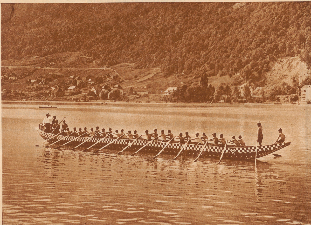
Bei uns: Die Bieler Gymnasiasten in dem neuen galeerenähnlichen Boot, das an den Ufern des Bielersees großes Aufsehen erregt. Diese Ruderstunden gehören zum Turnprogramm der Schule und stellen eine fröhliche und sinnvolle Neuerung dar
